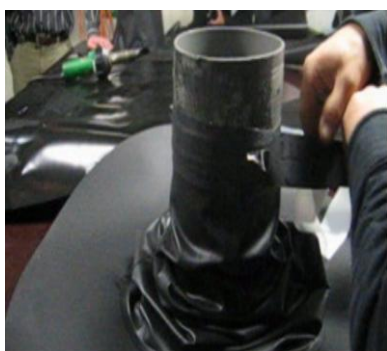
Свързване чрез самовулканизираща се лента
