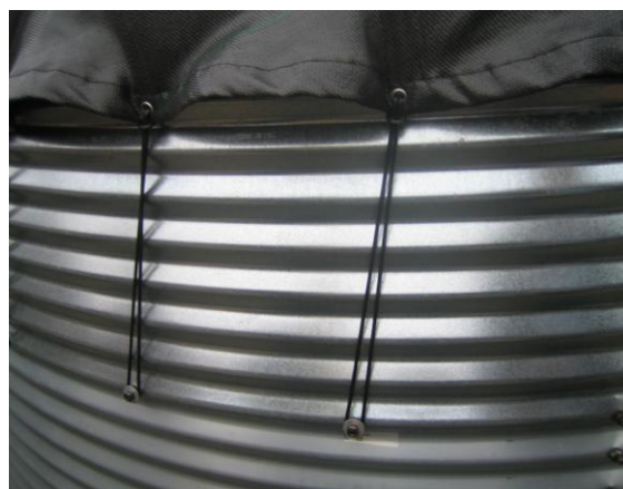
Анкерира се към резервоара посредством каучукови анкери и с използване на галванизирани болтове от комплекта на резервоара
