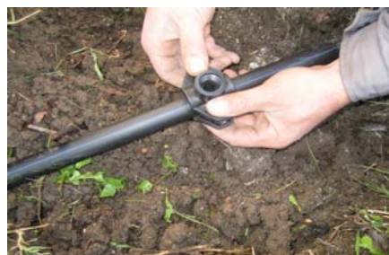
Закрепва се горната част на водовземната скоба към вече положената основа и се пристяга с болтовете
