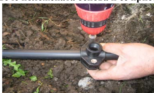
Закрепва се горната част на водовземната скоба към вече положената основа и се пристяга с болтовете
