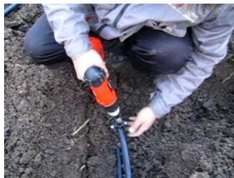
Пробиване на отвор в ПЕ тръбата
