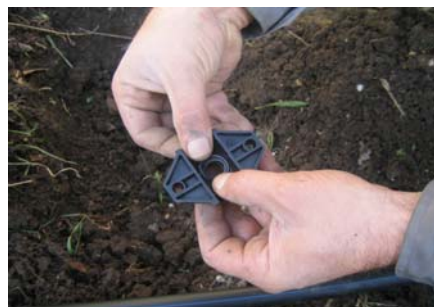
Проверка на уплътнителната гума
