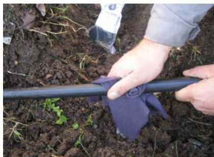
Почистване на полиетиленовата(ПЕ) тръба от механични замърсители
